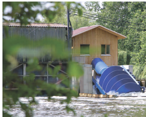
48.1 KW System, Baiersdorf
